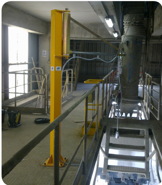
Fourniture et pose d'une potence sur mesure
